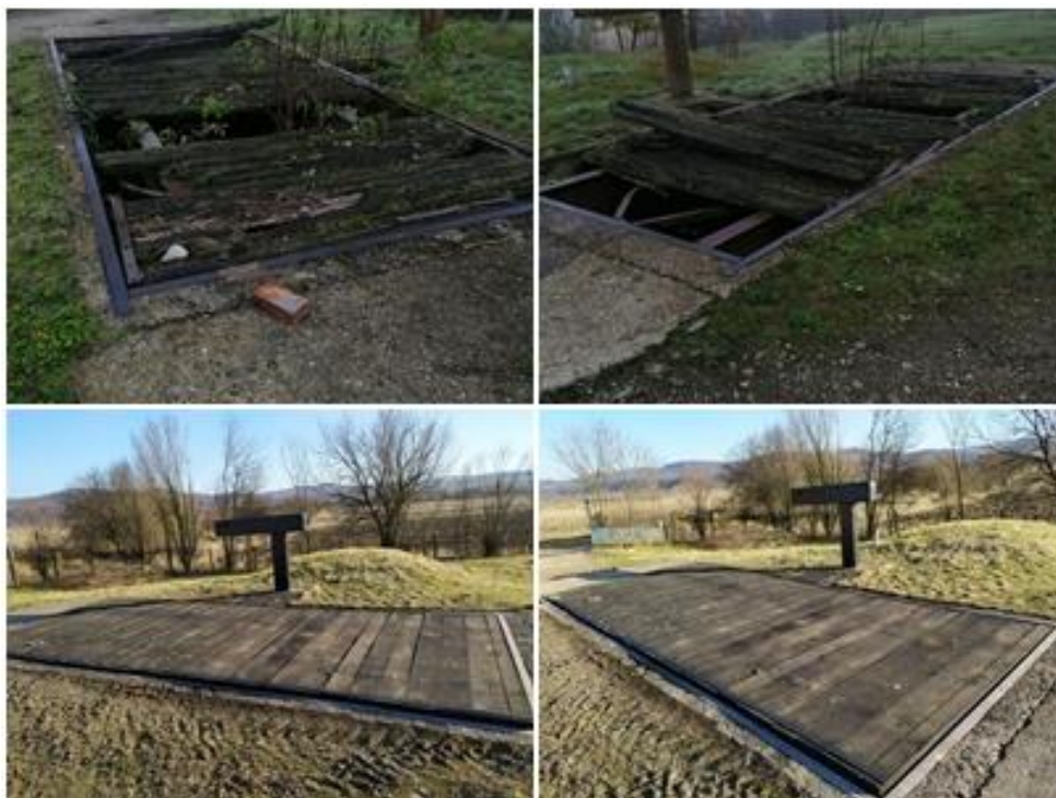
Foto 23. Cantarul de mare capacitate de la sediul pepinierii inainte (sus) si dupa (jos) reabilitare
