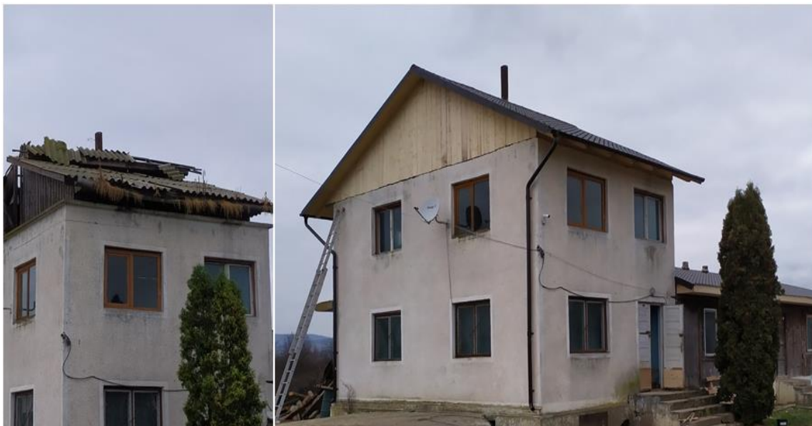
Foto 22. Acoperisul sediului de ferma de la pepiniera inainte (stanga) si dupa (dreapta) reabilitare
