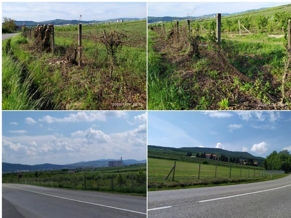
Foto 18. Gardul de la soseaua DN 17 înainte (sus) și după (jos) înlocuire și amenajare
